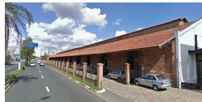
Figura 89. Vista do Ceprocamp a partir da Av. Dos Expedicionários. A edificação é tombada e foi reformada para receber o Centro Profissionalizante. A intervenção foi feita em aço e a área da frente foi transformada em estacionamento. O acesso se dá pelo portão mostrado à direita. Fonte: Google Street View. 2010.
