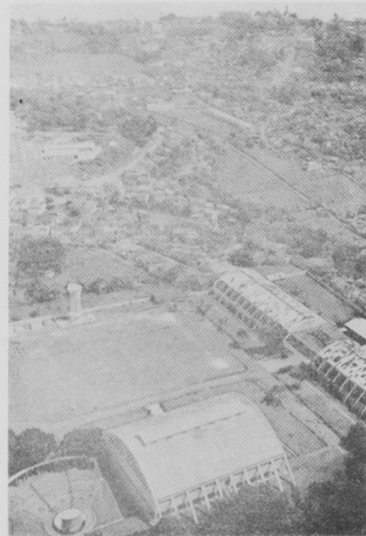
C.E.C.R. - Vista parcial
