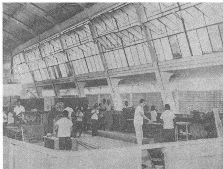
Atividades Industriais Pavilhão de Trabalho
